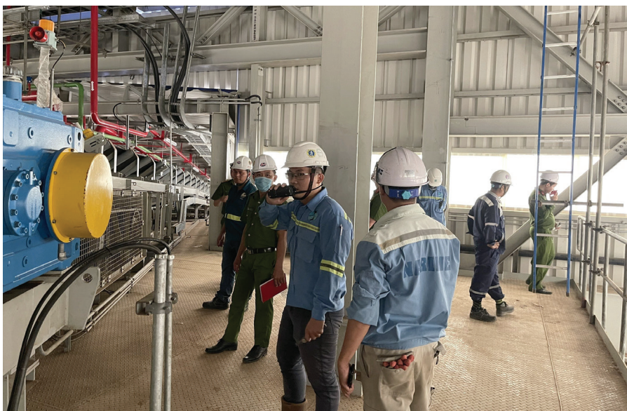
Các chuyên gia NARIME tiến hành nghiệm thu, chạy thử hệ thống.
