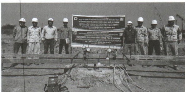
Hình 3.2: Gia tải thí nghiệm nén tĩnh
