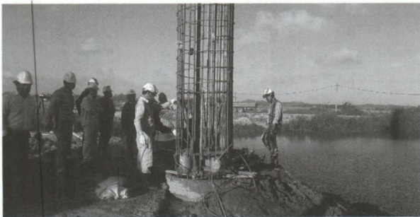
Hình 3.1: Lắp đặt hộp tải trọng
