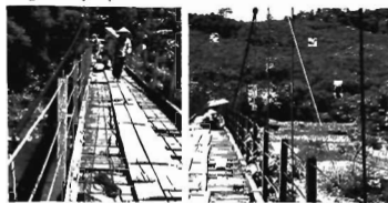
Hình 3.2: Hình ảnh thi công và tăng cường cầu Na Xá
