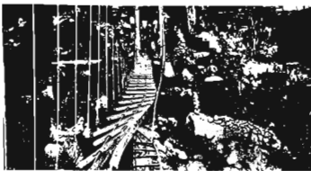
b) - Cầu Chu Va Hình 1.1: Hình ảnh cầu bị phá hủy
