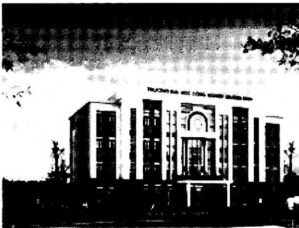
Hình 1. Hình ảnh Dự án Nhà điều hành A2, Trường DHCNQN đã khởi công xây dựng tháng 01/2022
