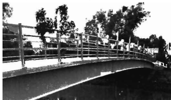
Hình 1.1: Kết cấu cầu thép cong dạng vòm đã được sử dụng cho cầu giao thông nông thôn
