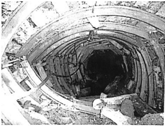
a) Đường lò xuyên vỉa +17 vị trí PK 348 bị nén lún do áp lực bãi thải
