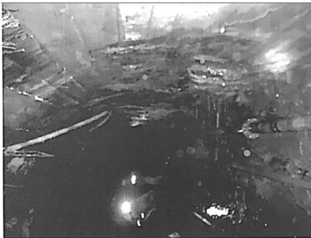
Hình 6: Vỏ chống bê tông lưu vì bị phong hóa
