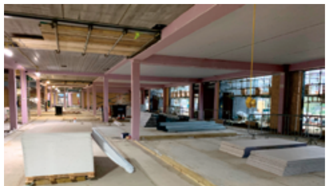
Hình 3. Dầm thép được sử dụng lớp vữa CAFCO bảo vệ chống cháy và dầm thép bọc thạch cao Gyproc
