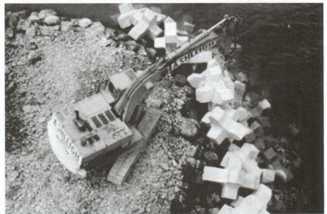
Hình 2.8: Cấu kiện Xbloc và một số hình ảnh về cấu kiện này
