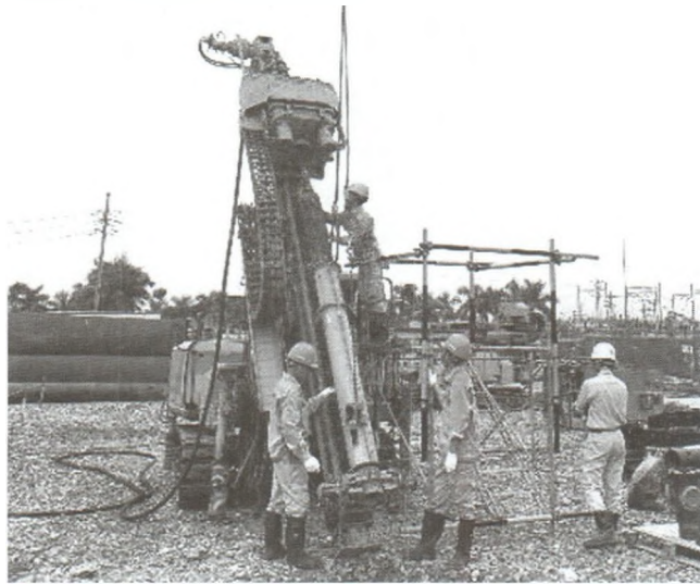
Hình 4.1: Định vị là lắp đặt thiết bị
