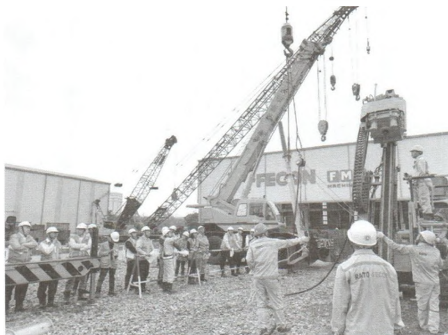
Hình 4.2: Lắp đặt nối thêm cần khoan
