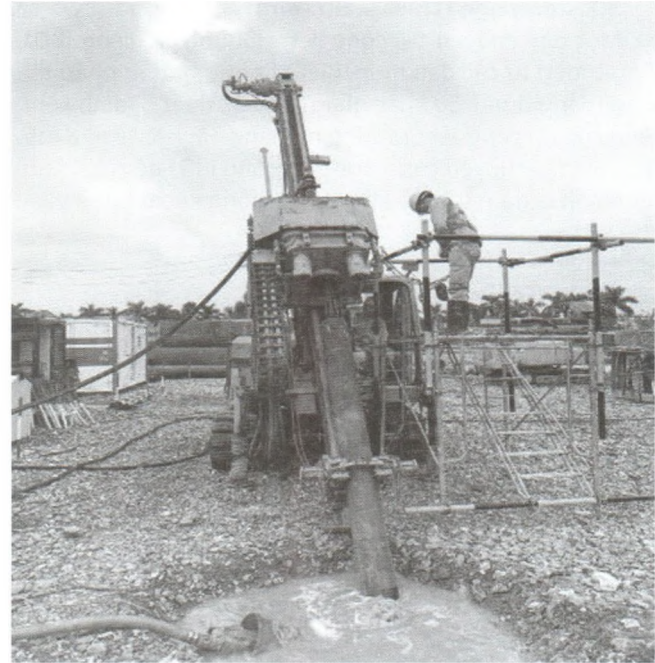
Hình 4.3: Khoan phụ vữa nghiêng 45°
