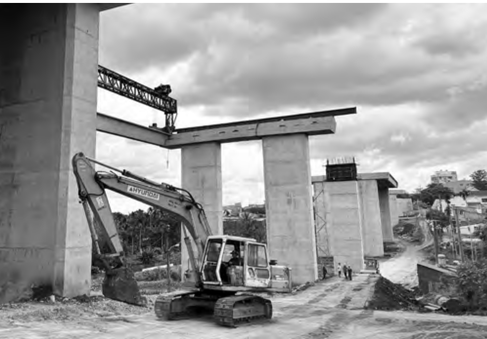
Công trình cầu đường Đinh Tiên Hoàng, thành phố Buôn Ma Thuột, Đắk Lắk
