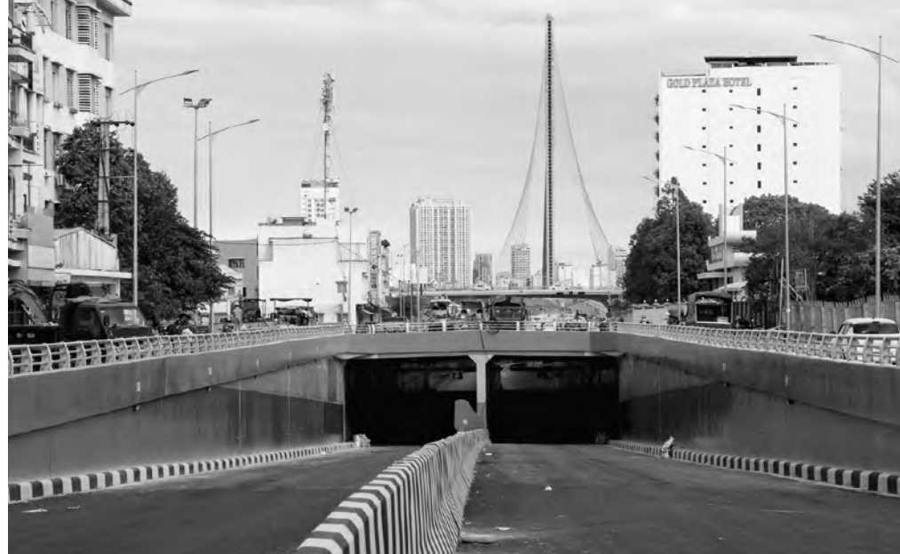
Công trình hầm chui phía tây cầu Trần Thị Lý, Đà Nẵng được xây dựng từ nguồn ngân sách thành phố sắp được đưa vào sử dụng.
