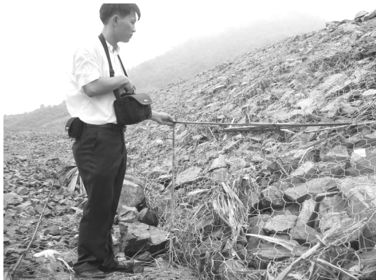
Hình 4. Mức nước cao nhất ở đỉnh đập xây dở theo vết lũ để lại
