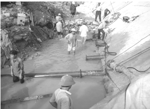
Hình 7. Ống thép tiêu nước bản chân
