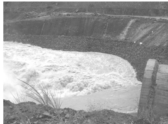
Hình 5. Nước chảy qua đường hầm dẫn dòng thời điểm chuẩn bị vỡ đập
