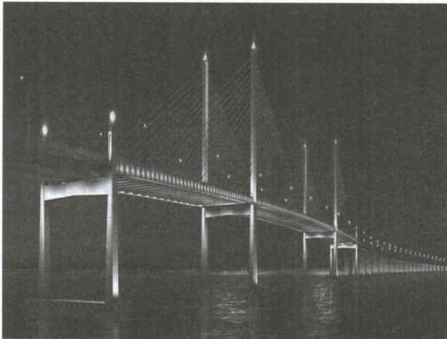
H.6 - Việc xây dựng cầu Penang thứ hai, kết nối giữa Batu Kawan trên đất liền và Batu Maung trên đảo Penang, bắt đầu vào tháng 11 năm 2008, và cây cầu đã được hoàn thành vào tháng 2 năm 2014. Vietkings (tổng hợp) - Theo Tổ chức Kỷ lục Đông Nam Á ( Aseanrecords.world )
