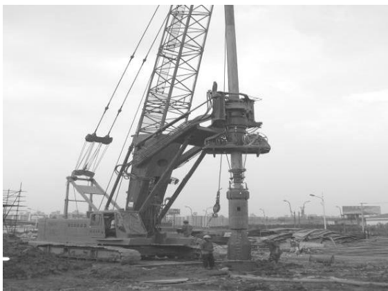
Hình 1: Hình ảnh thi công hiện trường
