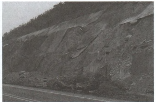
Hình 1. Sạt lở mái taluy trên đường cao tốc Hà Nội-Lào Cai dù đã gia cố mái, cắm ống tách nước
