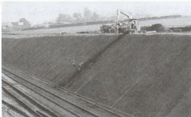
Hình 2. Sử dụng rãnh đá hộc để thu nước mái dốc
