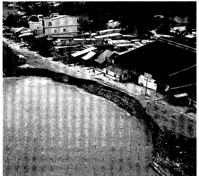
Hình 1.1: Sạt lở nghiêm trọng nền đường QL91, tỉnh An Giang (Ảnh H.Đương - Báo Pháp luật Hồ Chí Minh)
