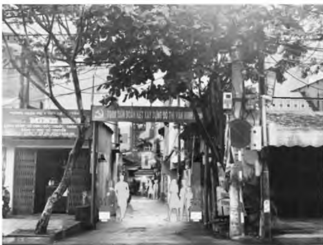
Hình 10. Phối cảnh tổng thể đề xuất cải tạo ngõ 54 đường Nguyễn Công Trứ, Đà Nẵng
