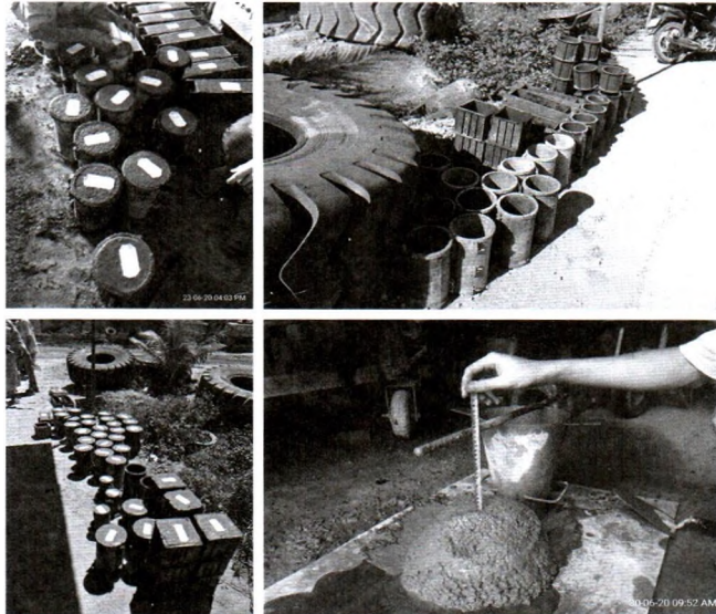
Hình 2.2: Chế tạo mẫu thí nghiệm bê tông hạt nhỏ làm đường sử dụng cát nhiễm mặn
