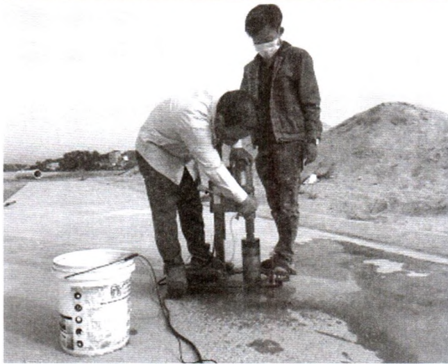
Hình 2.5: Các hình ảnh thi công ngoài hiện trường
