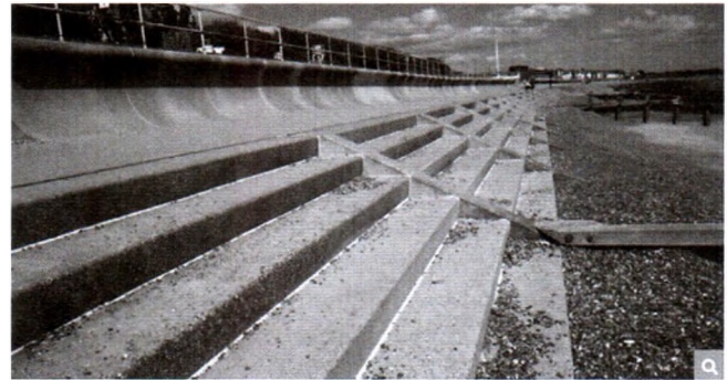
Hình 2.1: Mái nghiêng bậc thang tại Cleveleys nước Anh Theo [2], một số công trình gia cố bờ được sử dụng tại Mỹ.
