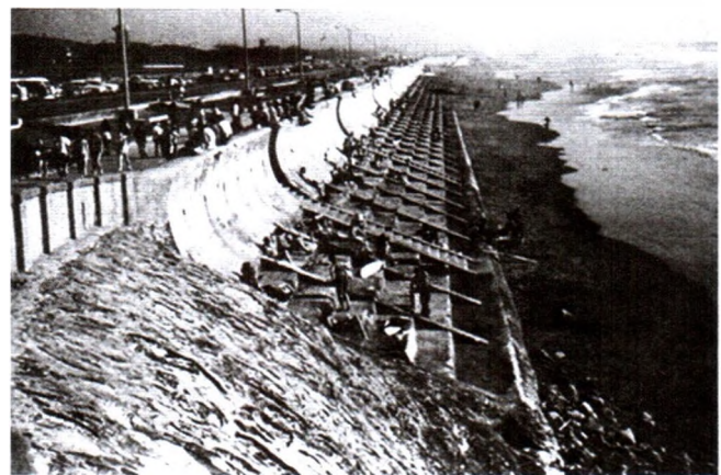
Hình 2.2: Mái nghiêng bậc thang tại Canifonia nước Mỹ
