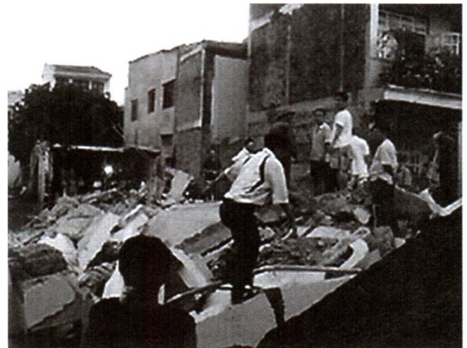
Hình 1.1a: Sự cố sập tòa nhà 4 tầng tại số 792C đường Nguyễn Kiệm - TP. Hồ Chí Minh năm 2007
