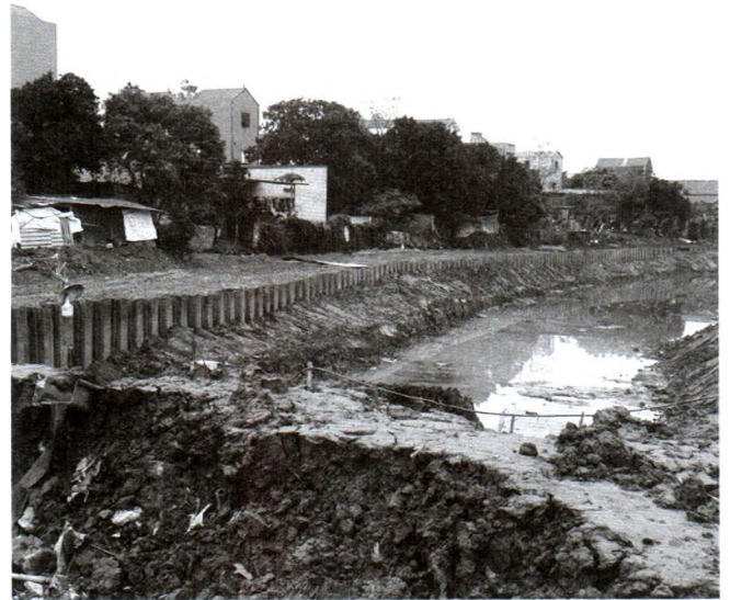
Hình 3.3: Thi công cừ tại vị trí sát nhà dân
