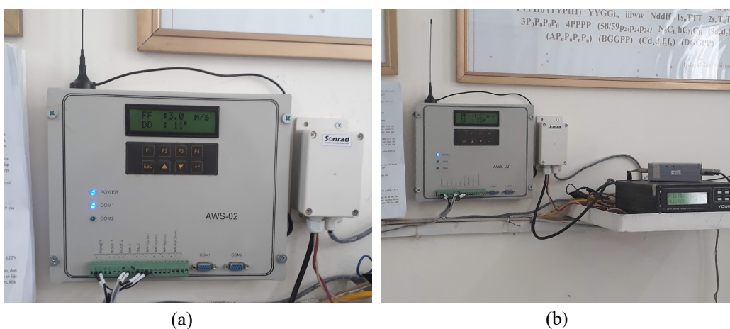
Hình 11. Kết quả hiển thị trạm Khí tượng Ninh Bình: (a) Bộ chuyển đổi sau khi hoàn thành; (b) Bộ chuyển đổi được kết nối với hệ thống gió cũ.
