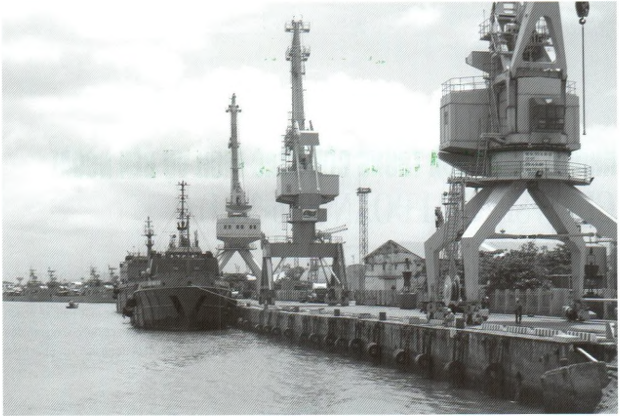
Hệ thống cầu ở cầu cảng Vietsovpetro.
