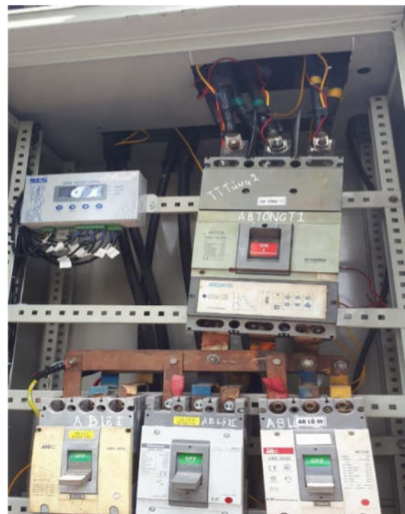
Hình 8. Hình ảnh lắp đặt thiết bị tại trạm biến áp
