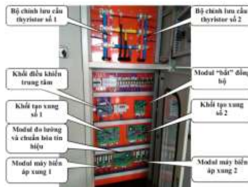
Hình 8. Các thành phần của tủ điều khiển kích từ động cơ đồng bộ
