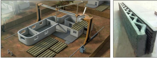
Hình 2. Mô hình kỹ thuật Contour Crafting in đường viền kết cấu và sản phẩm điển hình.
