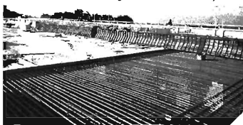
Hình 1.1: Cốt thép bản liên tục nhiệt
