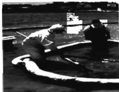
Hình 1. Xử lý dầu tràn bằng kỹ thuật hấp phụ với polypropylene.
