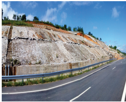
Hình 2. Che phủ bề mặt bờ dốc bằng đá xây và bê tông phun không hiệu quả khi áp dụng không phù hợp (đường cao tốc Nội Bài - Lào Cai, 2017).
