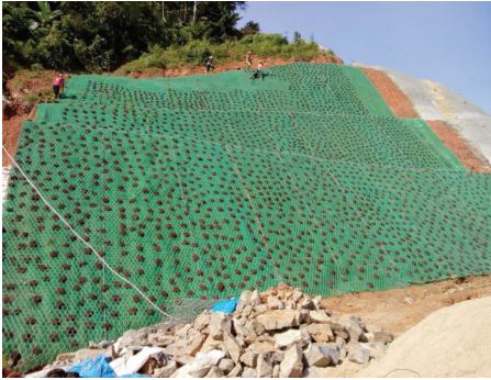
Khi vừa thi công xong
