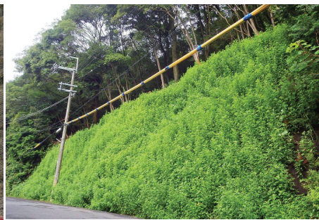
Sau 4 tháng thi công
