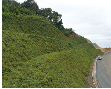
Sau 5 tháng thi công
