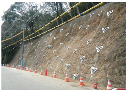
Khi vừa thi công xong
