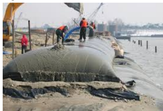
Hình 3. Ống vải địa kỹ thuật (Geotubes).
