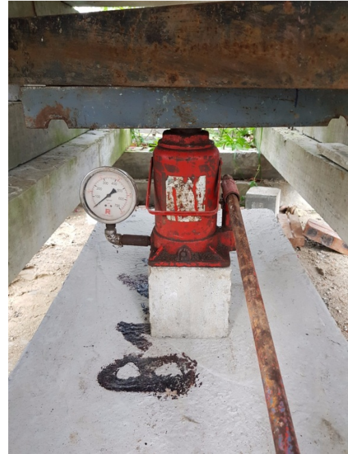
Hình 9. Thí nghiệm chịu uốn của bản bê tông cốt thanh FRP.
