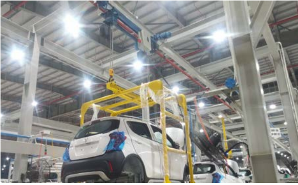
Hình 9. Hình ảnh cầu trục số 4 đang làm việc tại nhà máy.
