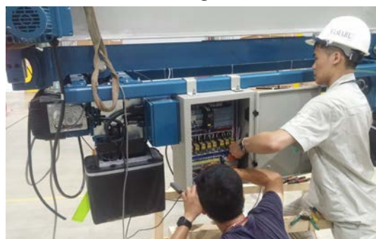
Hình 7. Lắp tủ điều khiển vào cầu trục.
