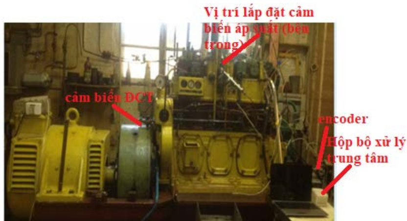
Hình 1. Hình lắp đặt các thiết bị trên động cơ 1417,5/24.
