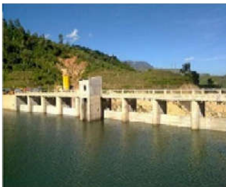
Hình 5: Cửa van tự lật - Công trình thủy điện Tà Lơi 2, Lào Cai
