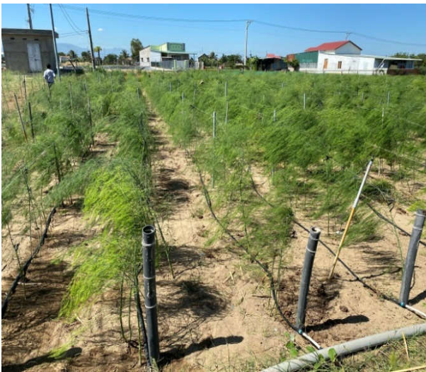
Hình 12: Khu tưới nhỏ giọt cho cây măng tây đã hoàn thành
