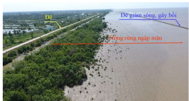
Hình 12: Giải pháp bảo vệ bờ biển đa tầng điển hình ở Cà Mau
