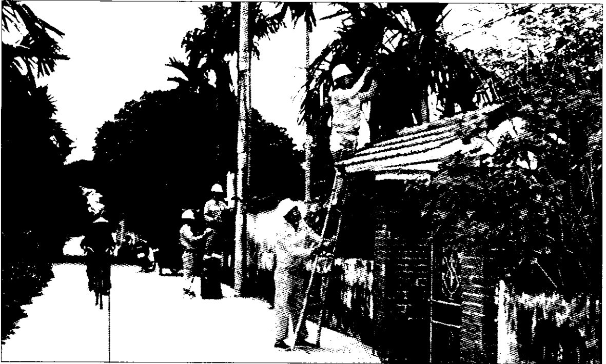
Đưa điện về nông thôn, thúc đẩy kinh tế - xã hội phát triển _ Ảnh: evn.com.vn
