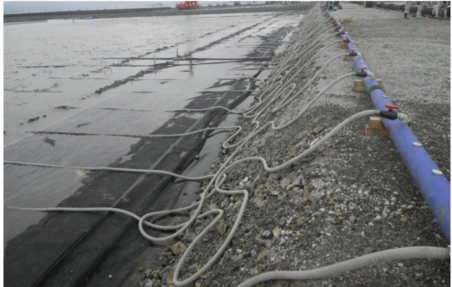
Mô hình thi công gia cố đất bùn bằng thoát nước và hút chân không tại Nhật Bản.
