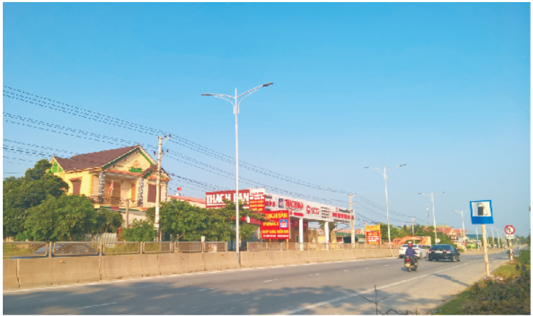
Bộ mặt nông thôn mới ở xã Lý Trạch, huyện Bố Trạch
